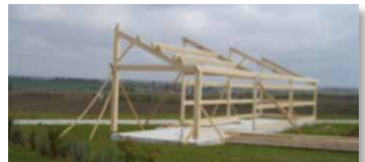
Début de construction du bâtiment
