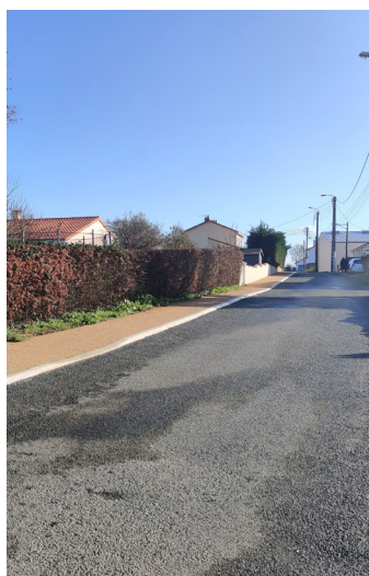
FINALISATION TRAVAUX DE LA PETITE ISLE : 18 K€
